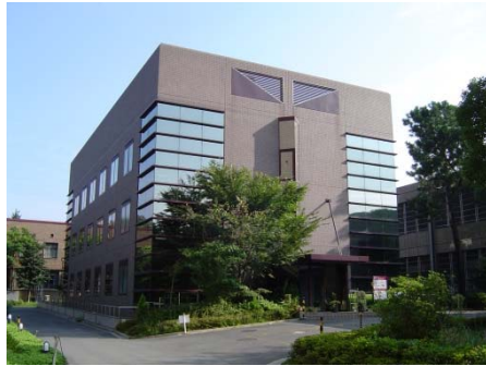
京都大学ベンチャービジネスラボラトリー棟 (国立大学第1号免震:1997年竣工)
