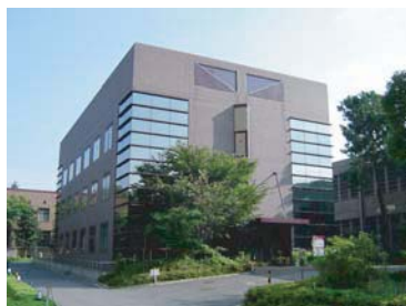
図5 京都大学ベンチャービジネスラボラトリー棟(国立大学第1号免震)
